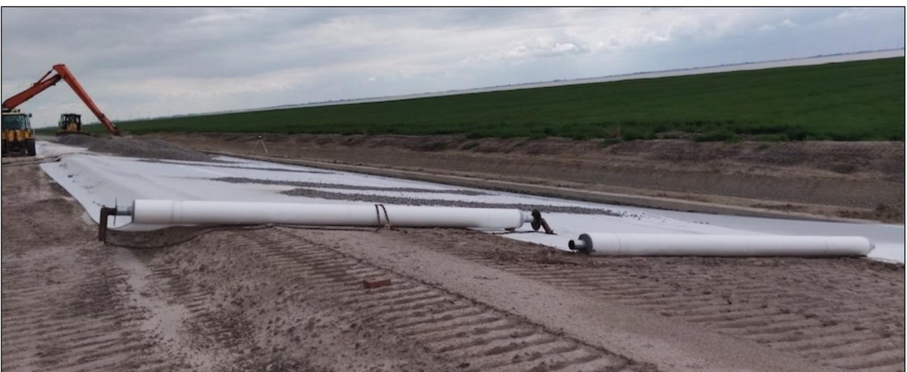
Bauarbeiten unmittelbar am Rand des Naturparks Wattenmeer. Rechts vom Deich, dessen Deckwerk unterfüttert auf den Folien liegen wird, verläuft ein Entwässerungsgraben, dahinter ein kleiner Wall.
